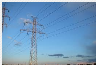
تامین تجهیزات و اجرای خط انتقال 132 kv طیس - دیهوک و شهرک صنعتی خوسف
