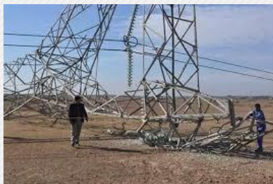
طراحی، تامین تجهیزات و اجرای خط انتقال 110 kv سلما - کرخ
