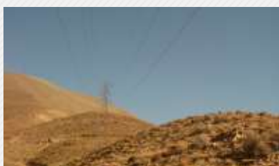
خرید برج و یراق آلات و عملیات اجرایی برج بندی و سیم کشی خط ۶۳ کیلوولت زاهدان - محمدآباد کورین
