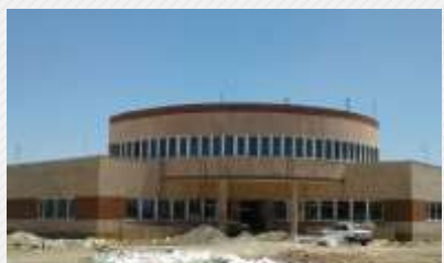
احداث کلینیک ویژه تیپ ۵۰۰ مترمربع شهر گلپهار
