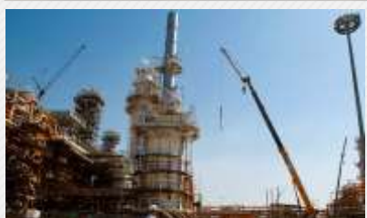
نصب تجهیزات نگهدارنده کابل و عملیات کابل کشی ۲۳۰ کیلوولت آزادگان - فورخانه
