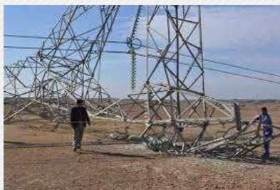
طراحی، تامین تجهیزات و اجرای خط انتقال ۱۱۰ kv سلما - کرخ
