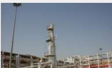
اورهال واحدهای ۴ و ۳ BBC نیروگاه شمال غرب کابل
