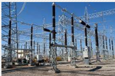
احداث پست برق ۱۳۲/۲۰ کیلوولت شهرک صنعتی اسفراین و خط ۱۳۲ کیلوولت دومداره ارتباطی
