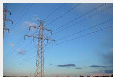
تامین تجهیزات و اجرای خط انتقال ۱۳۲ kv طیس - دیهوک و شهرک صنعتی خوسف
